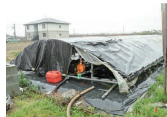
設置している貯水タンク
